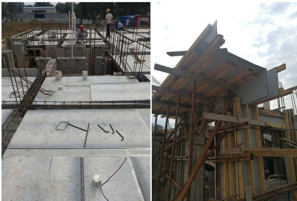
Рисунок 2. Монтаж несъемной опалубки из цементно-стружечных плит.
