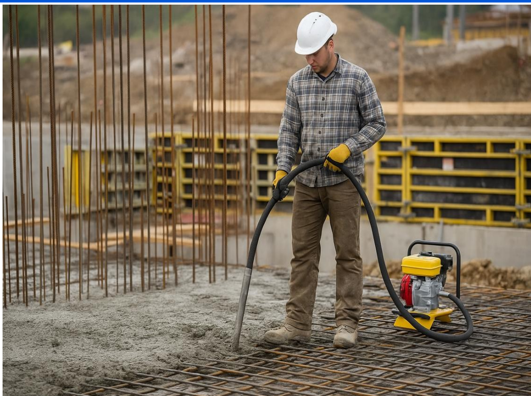
Рисунок 3. Процесс бетонирования в несъемной опалубке.
