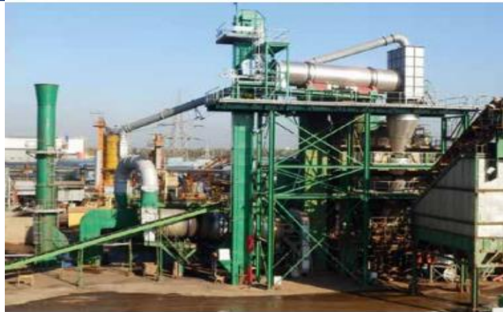
2- rasm ABZ-4 Kapotnya (Moskva) da ikkilangan quritish barabani yordamida eski asfaltbetonni qayta ishlash
