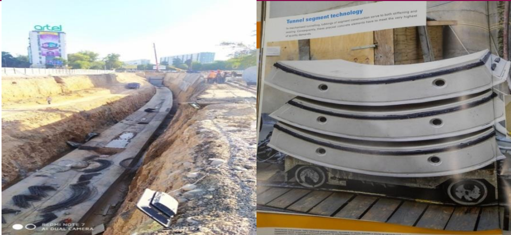
Юнусобод йўли Туркистон метро бекатигача булган ер ости йулининг тубинг темирбетон констрүкциялари
